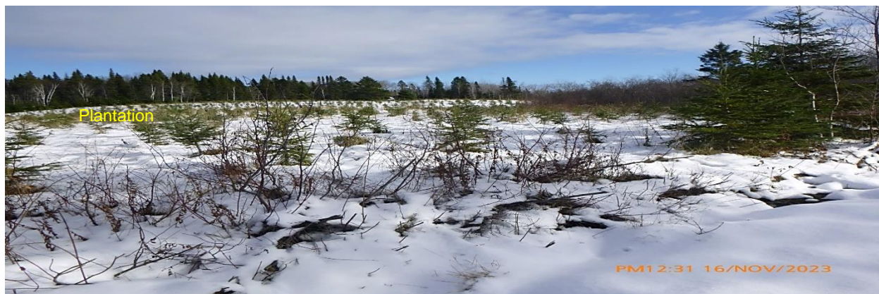
Figure 10 État du terrain à proximité de l'éolienne CM26
