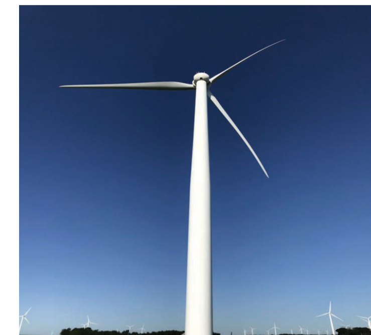
Site de l'éolienne
